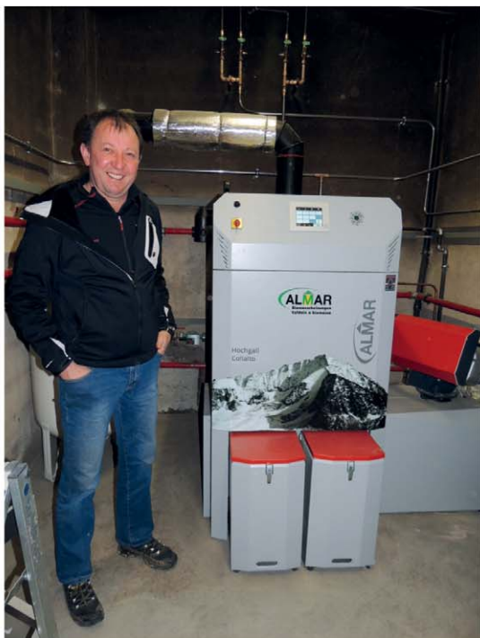
▲ Carpenteria Silgoner Hubert S.A.S, Rodengo (BZ) foto: almar
